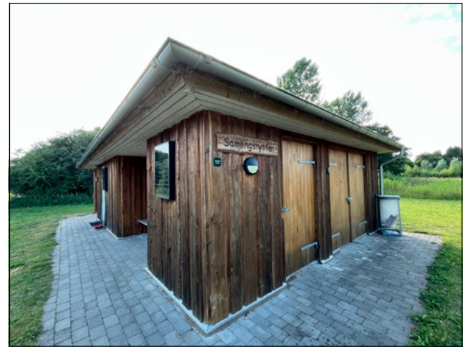
Samlingshytten indeholder toilet/handicaptollet, bad med varmt vand og et mødelokale.
