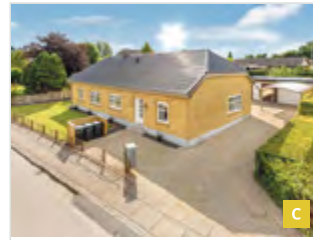
Østergade 10 Bolderslev Indflytningsklar bolig
