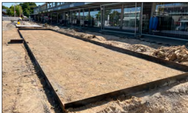
I juni startede arbejdet med de nye parkeringslommer.
