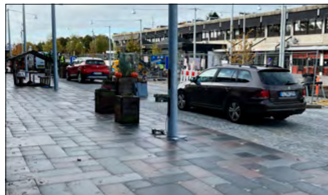
Den 23. oktober er kørebane, parkeringspladser og lysmaster på plads.
