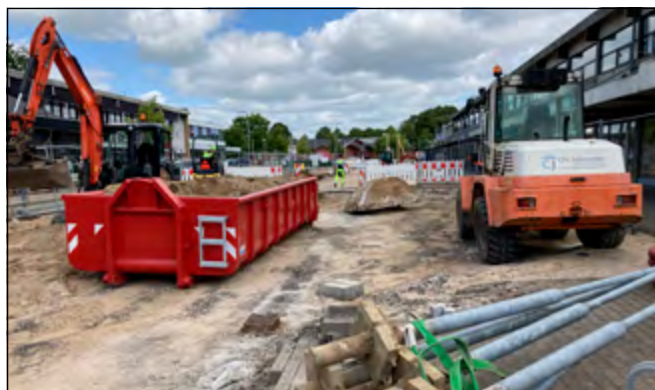
Den 4. juni var Torvecentret forvandlet til én stor byggeplads. Foto Helle Hockerup
