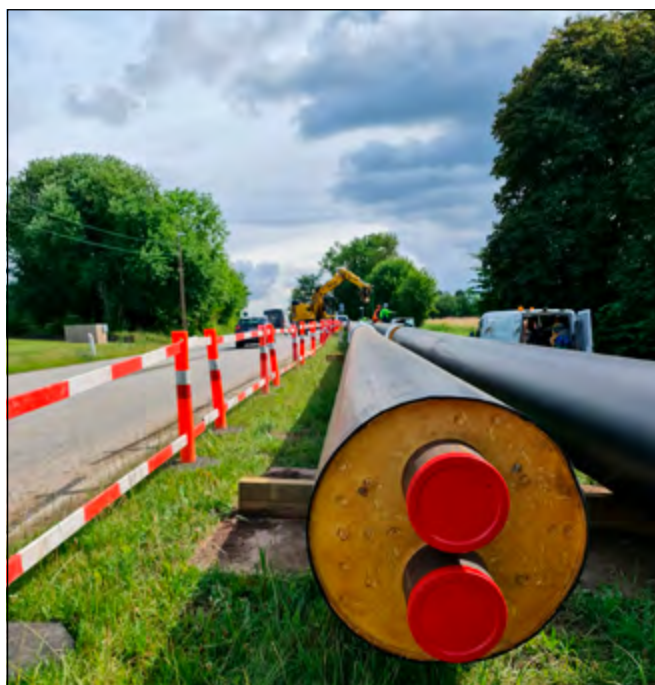
Sønderborg Varme er i gang med at nedlægge fjernvarmerør.
