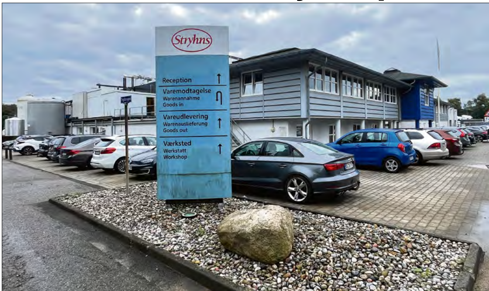
Stryhns vil nedrive de gamle bygninger på Teglværksvej og opføre en ny kæmpe fabrik.
