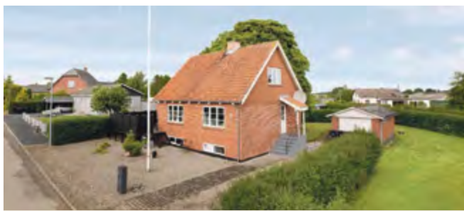
Indflytningsklar villa i Avnbøl
