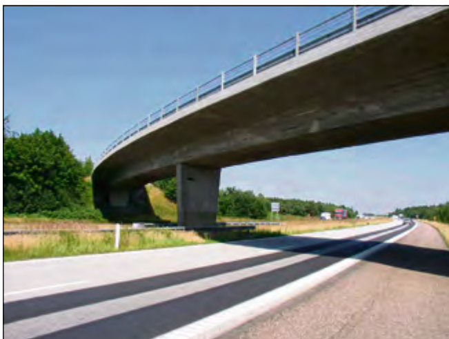
Afspærringen af motorvejsbroen forventes at vare fra den 21. august til den 10. september. Foto: Vejdirektoratet.
