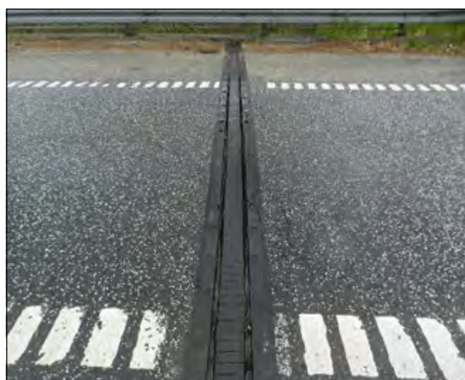
En af broens dilatationsfuger, der sørger for, at broen kan bevæge sig ved temperatursvingninger. Foto: Vejdirektoratet.
