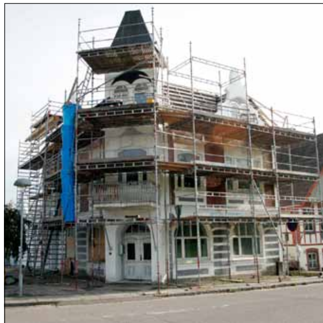
Håndværkere er for tiden i gang med at lægge nyt tag på en af de markante bygninger i Varnæs. Foto Jimmy Christensen
