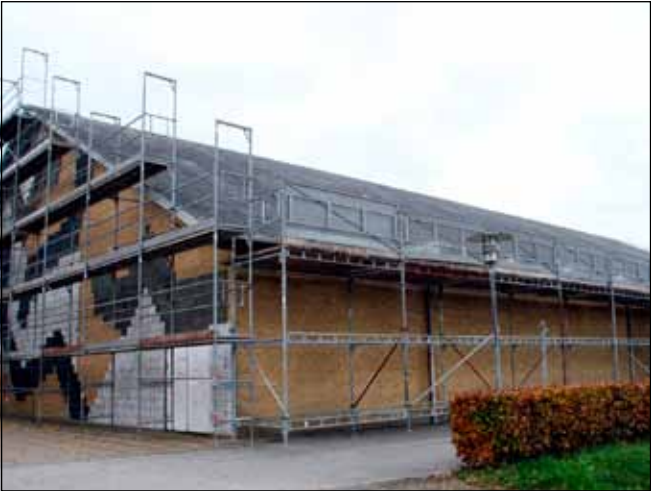
For tiden bliver der lagt nyt tag på Broager-Hallen. Sydsiden er allerede færdig, men nordsiden står færdig i uge 50. Foto Jimmy Christensen
