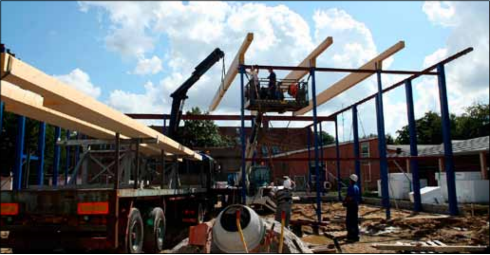
Der er rejsegilde på fredag på den nye hal i Kværs.
