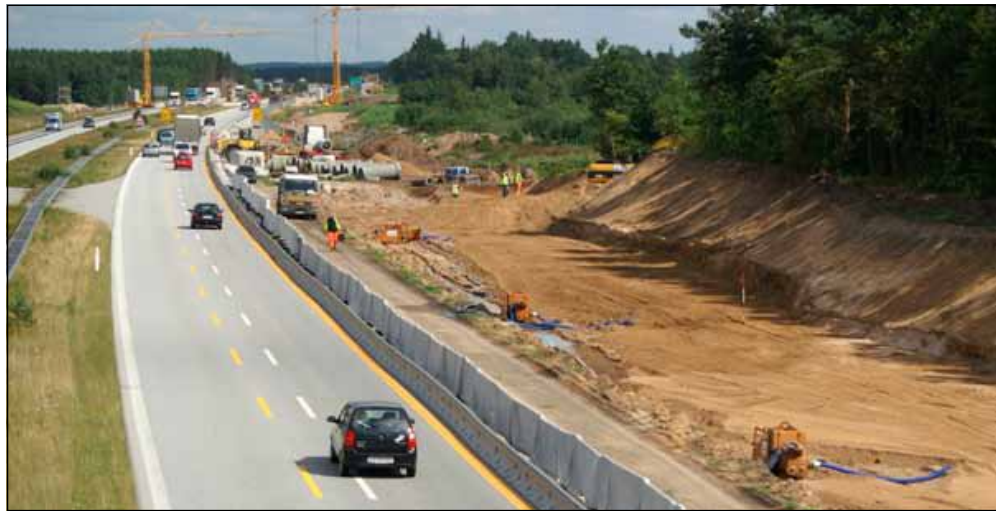
Arbejdet er i fuld gang på den nye motorvej Kliplev-Sønderborg.
