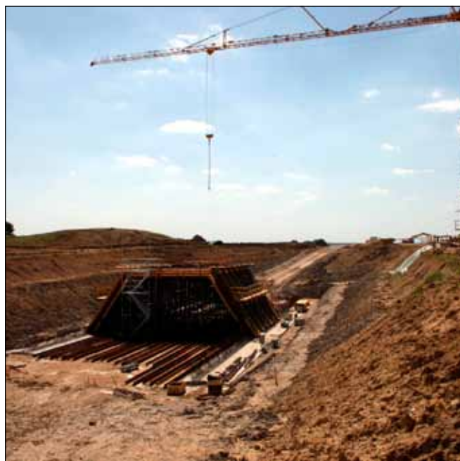
Støbningen af broen ved Avnbøl er gået i gang.
