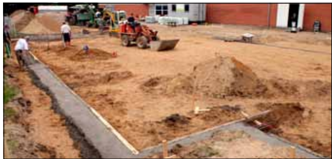
Byggeriet af den nye multihal i Kværs er godt i gang.
