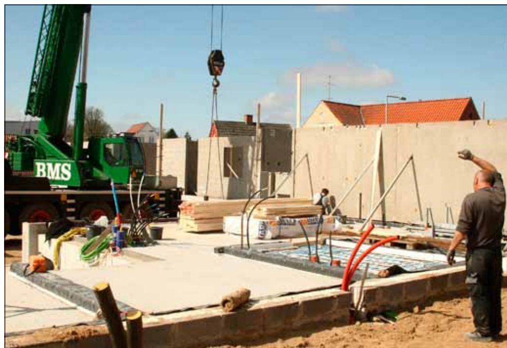
Store BMS kraner løfter betonelementer på plads.
