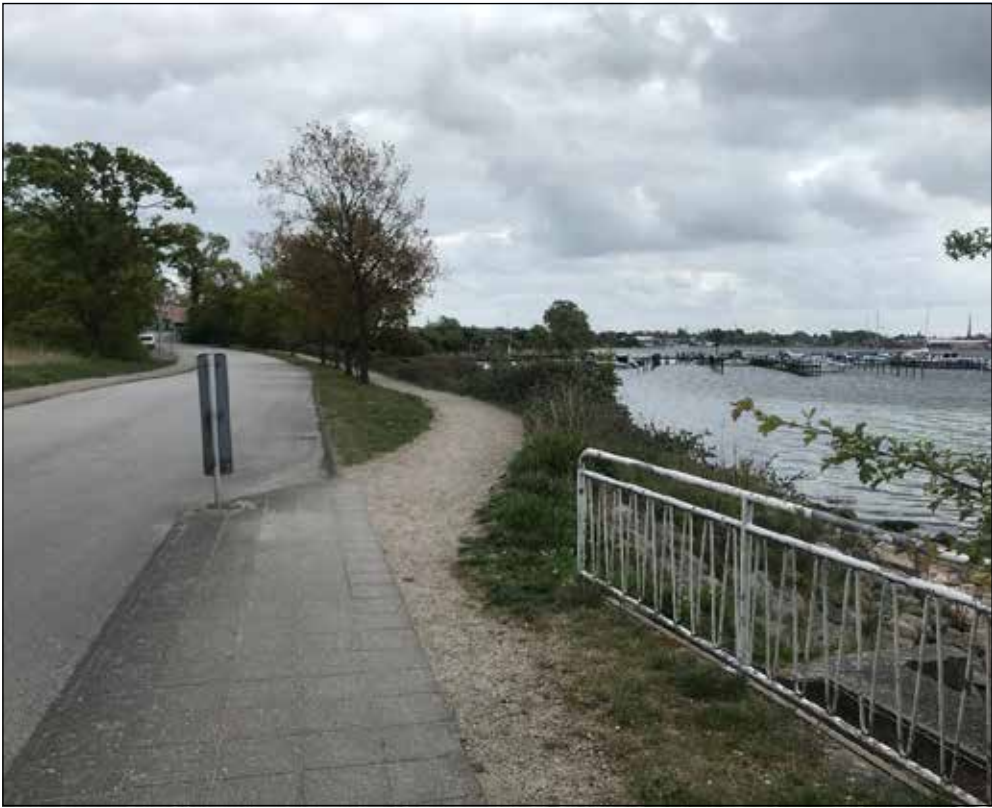
Sønderborg Kommune etablerer en højvandsmur langs med Fiskenesvej i Gråsten.
