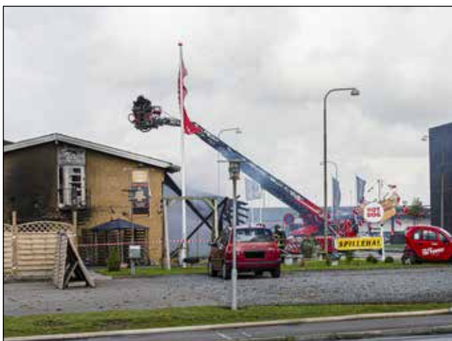
Spillehal Padborg på Industrivej i Padborg blev flammernes bytte. En mand indebrændte i bygningen.
