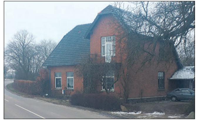
Buskmosevej nr. 10 er huset som Ulla Clausens bedstefar i sin tid byggede.
