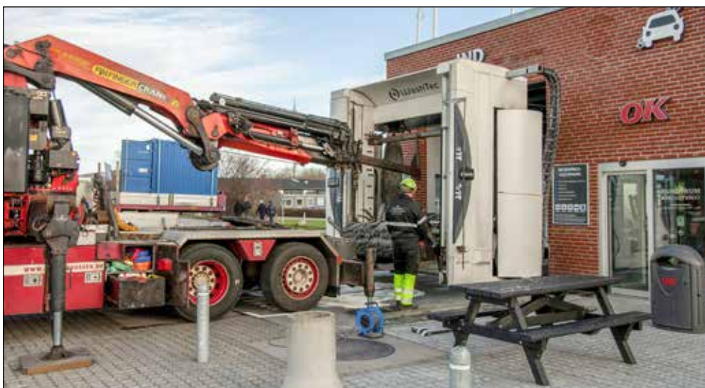
Vaskehal 1 er ved at blive renoveret.
