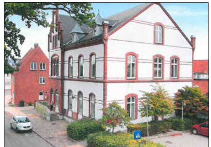
Gråsten Andelsboligforeninger overtager Posthuset, som skal være administrationsbygning.
