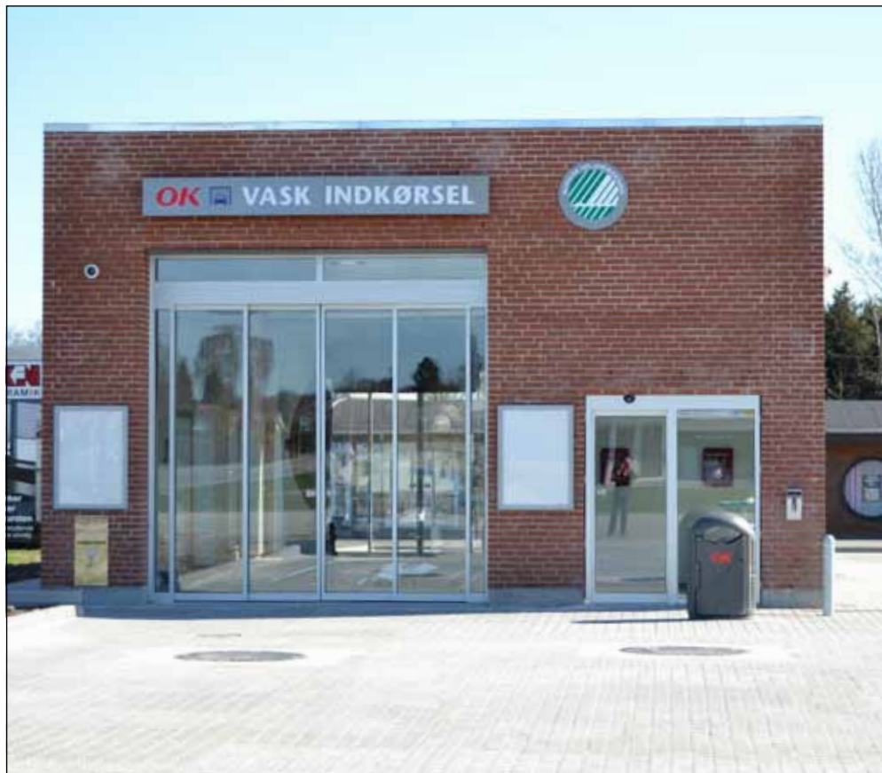
Den nye vaskehal på Sundsnæs er klar til at blive taget i brug.
