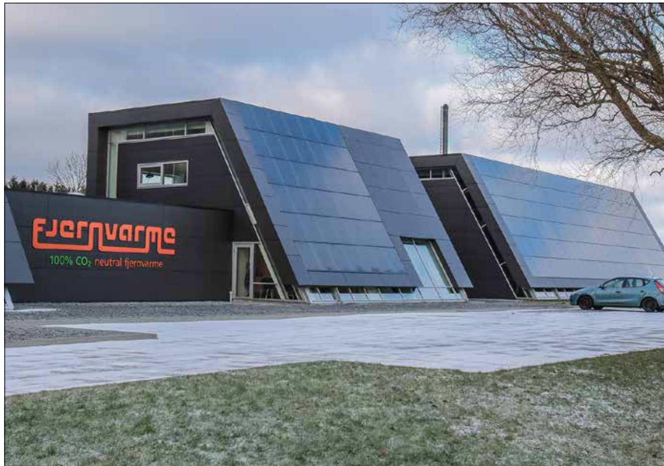
Gråsten Fjernvarme udvider i 2016 med solpaneler på Sønderborg Landevej i Gråsten.
